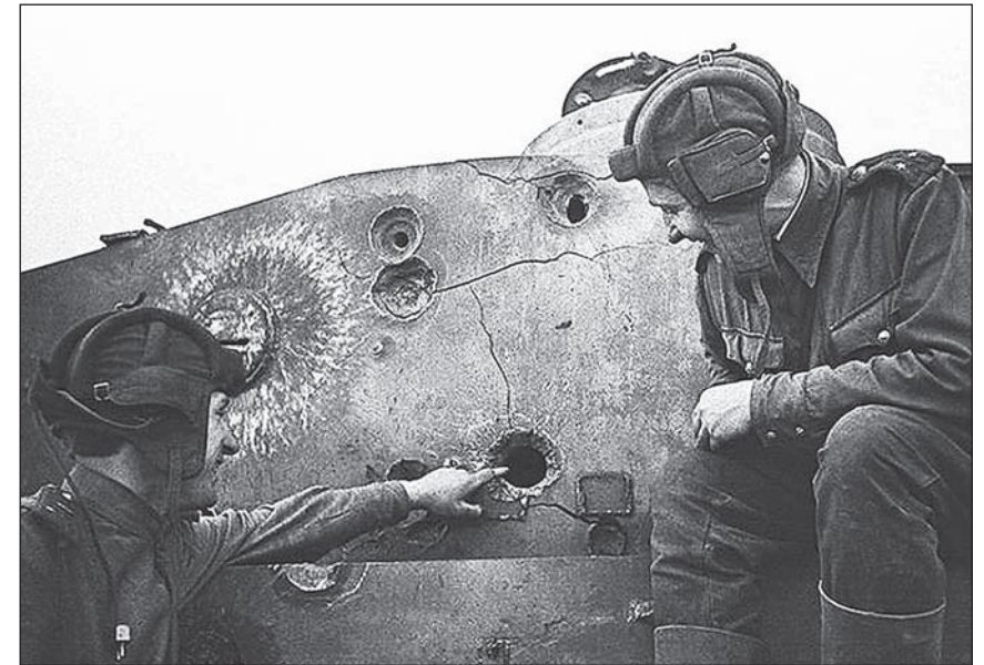
1943. Курская Дуга. Башня подбитого «Тигра» вся в трещинах от попаданий 76-мм снарядов
